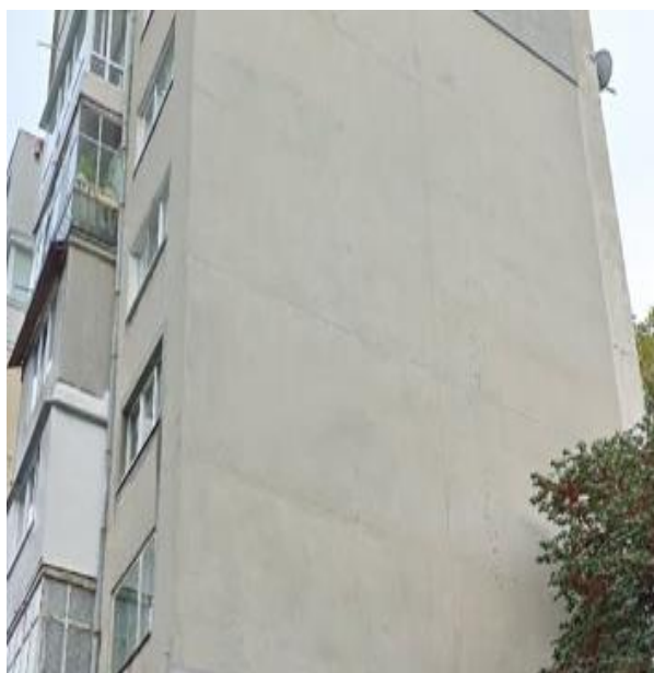
Фиг. 5 Външни фуги в добро състояние
