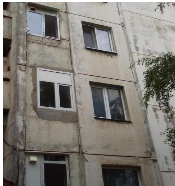
Фиг. 6 Външни фуги хоризонтални и вертикални в лошо състояние
