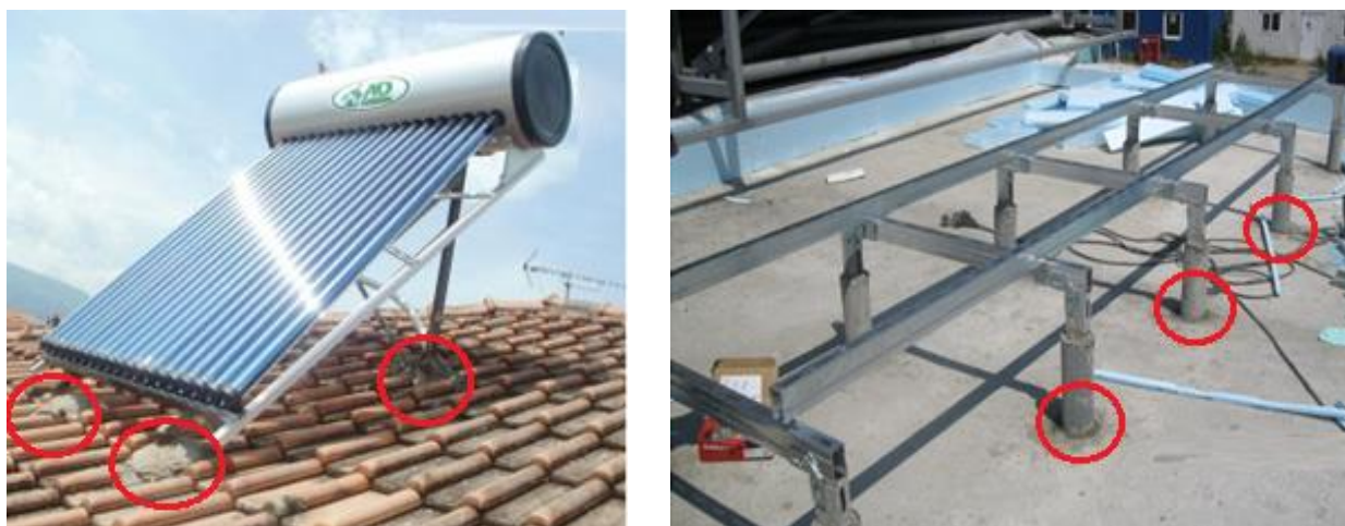
Фигура 3а,б. Начини на монтиране на колектор върху наклонен покрив
