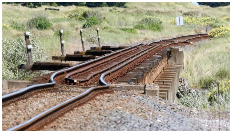
Фигура 7. Загуба на устойчивост на железен път при сеизмично събитие с магнитуд 7.8 в южен Marlborough - DEREK FLYNN/FAIRFAX NZ [7]
