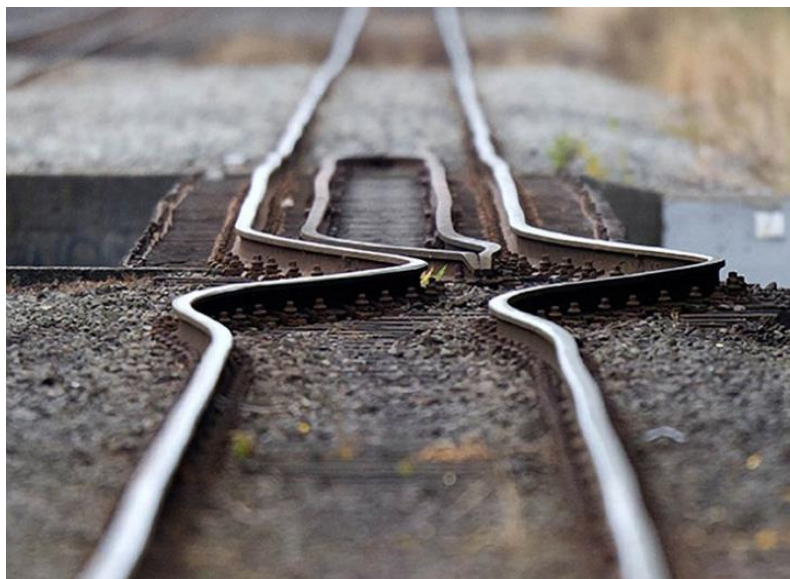
Фигура 6. Загуба на устойчивост на железен път при сеизмично събитие [8]
