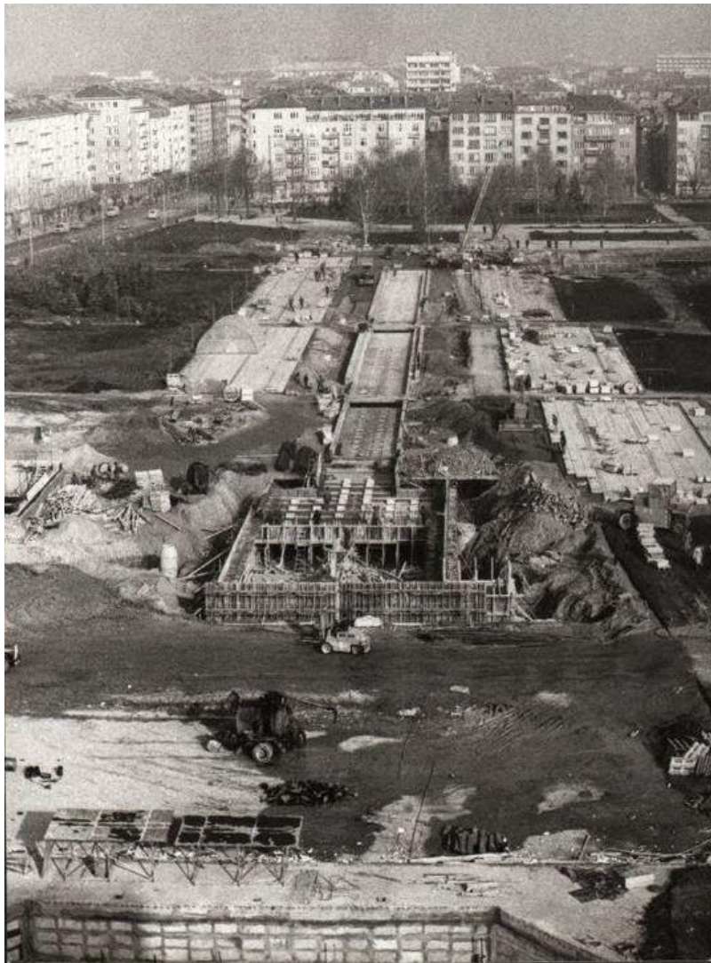
Фигура 2. Площада гр. София НДК а) изпълнение на нова основа, върху която е положена нова хидроизолационна система (фотография: http://www.skyscrapercity.com ) б) площадът е изграден през 1987 година
