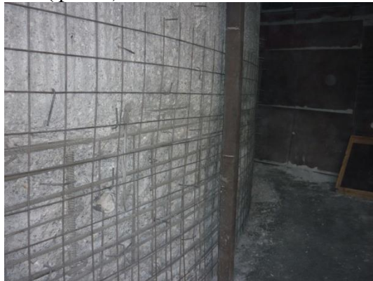
Фигура 2. Подготвена повърхност с анкерирана стоманена мрежа
