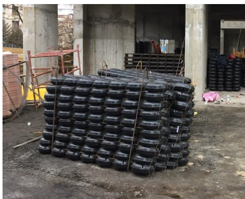
Фигура 5. Складиране на елементите от система Sobiax при монолитно изпълнение а) и при смесено изпълнение б)
